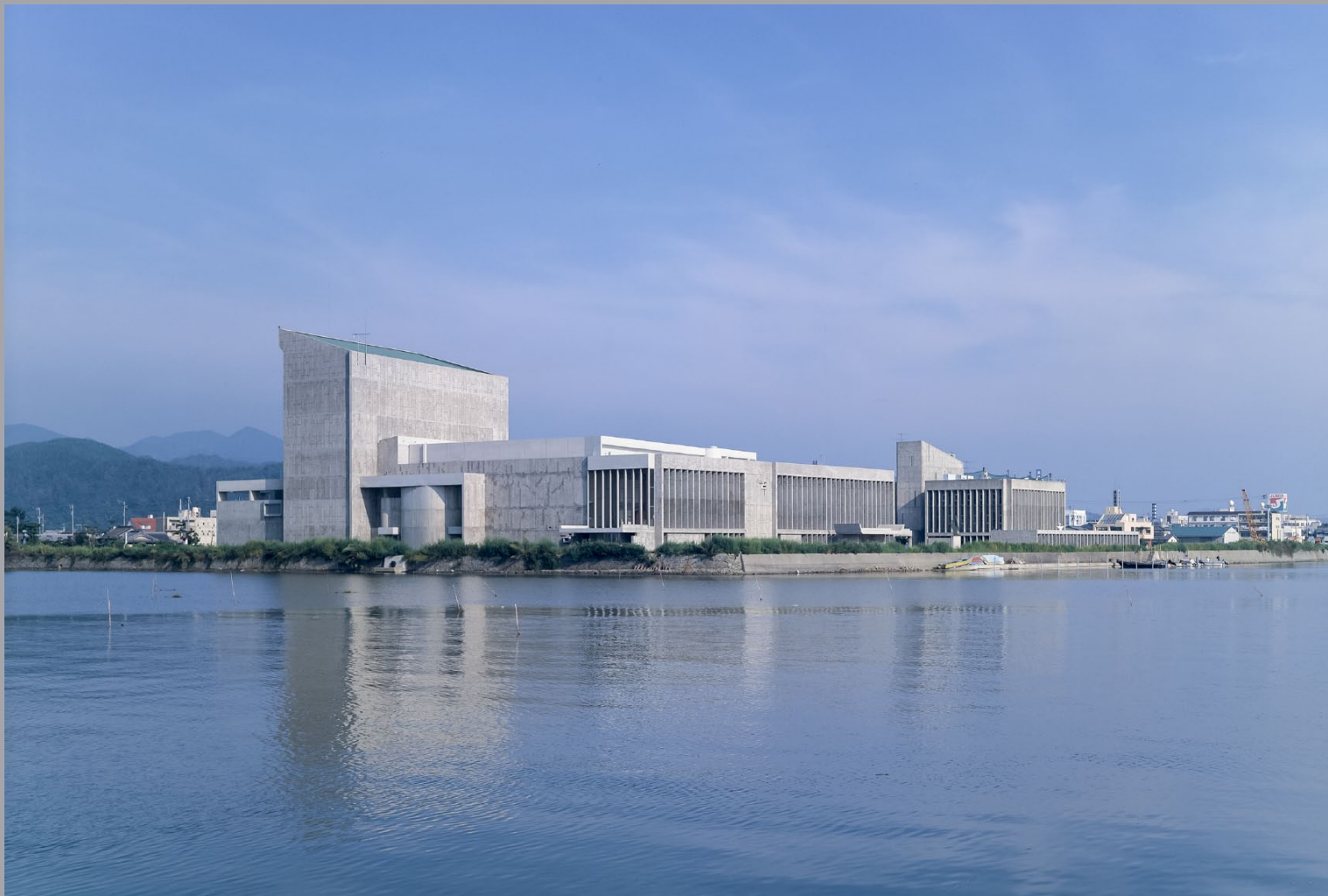
鳴門市文化会館 (撮影：新建築社写真部)
